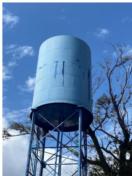
Foto 37 – Pequenos Vazamentos no reservatório
