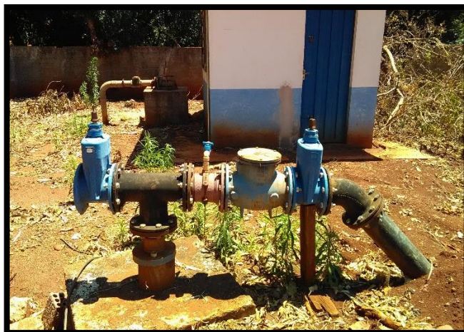
Imagem 07: Barrilete do poço da Rua Aurora
