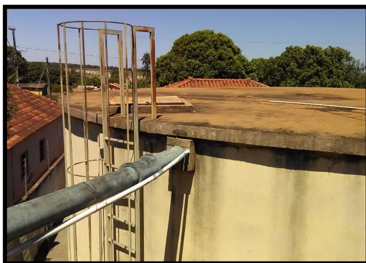
Imagem 10: Reservatório apoiado Caixa 2
