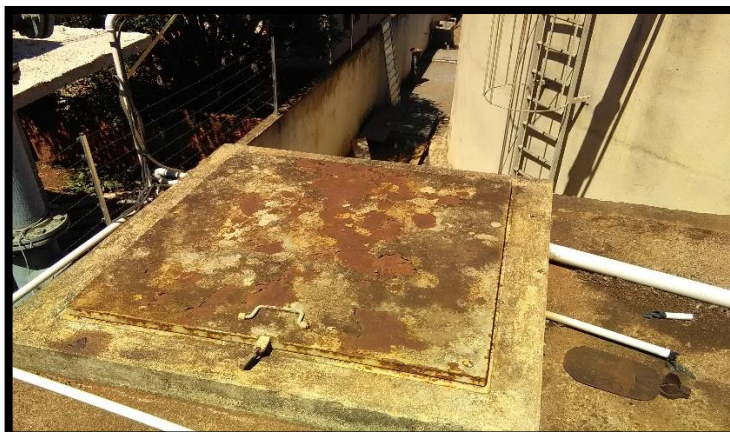
Imagem 09: Abertura de inspeção do reservatório Caixa 1
