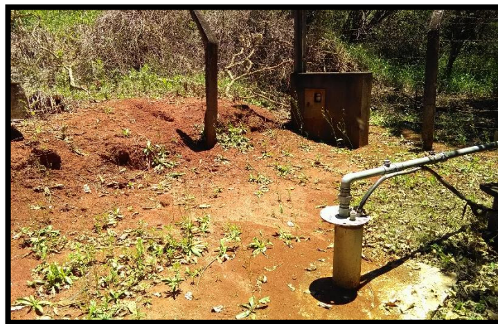
Imagem 03: Poço da fazenda Ingá-Mirim
