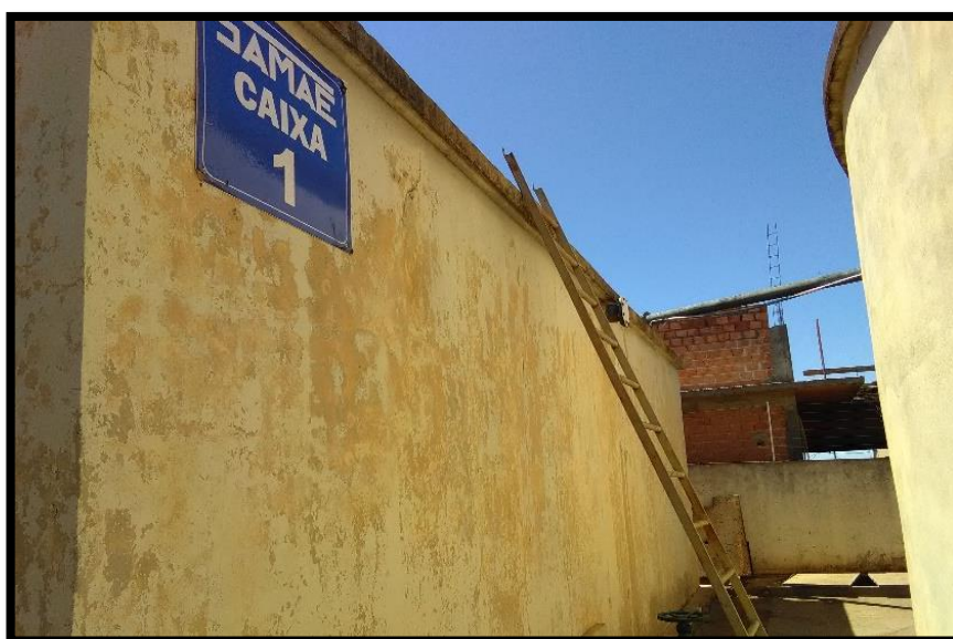
Imagem 08: Reservatório apoiado Caixa 1
