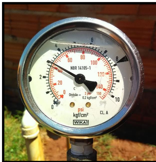
Imagem 15: Medição na Rua José Aparecido Lopes
