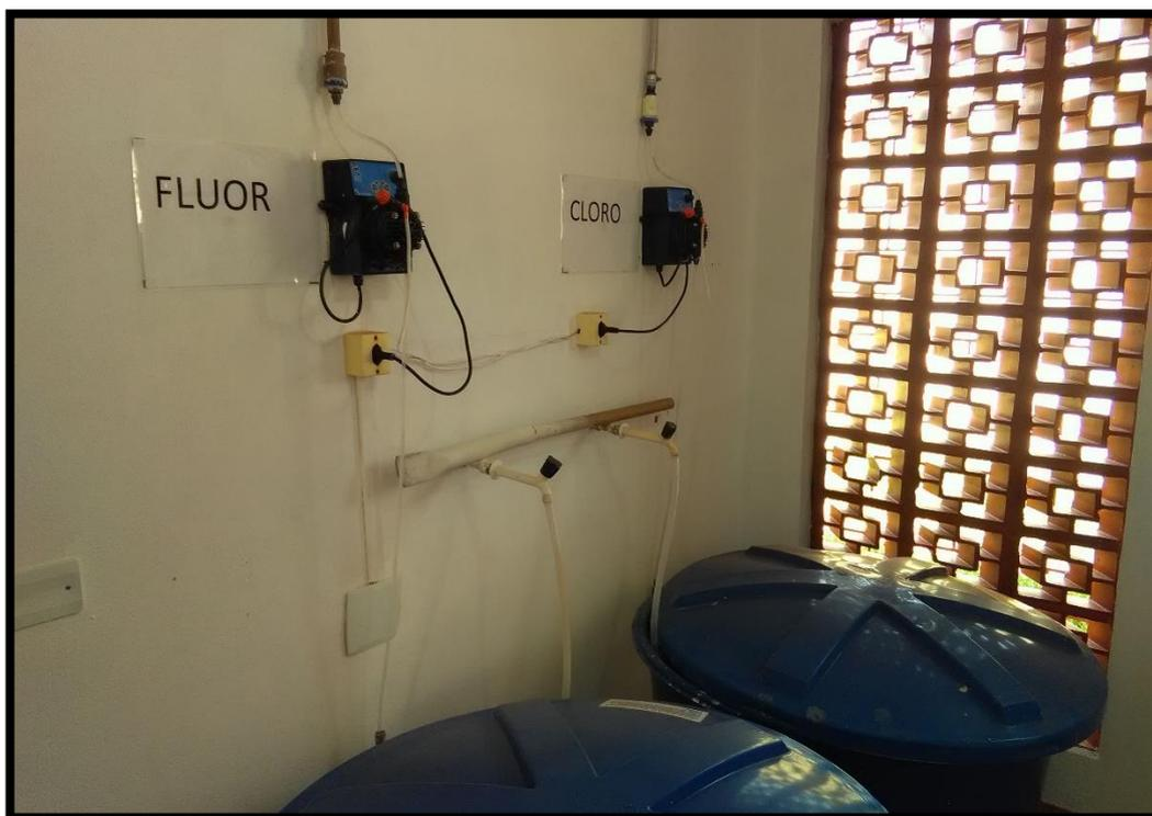
Imagem 10: Dosadora e reservatórios de cloro e fluor de cloro
