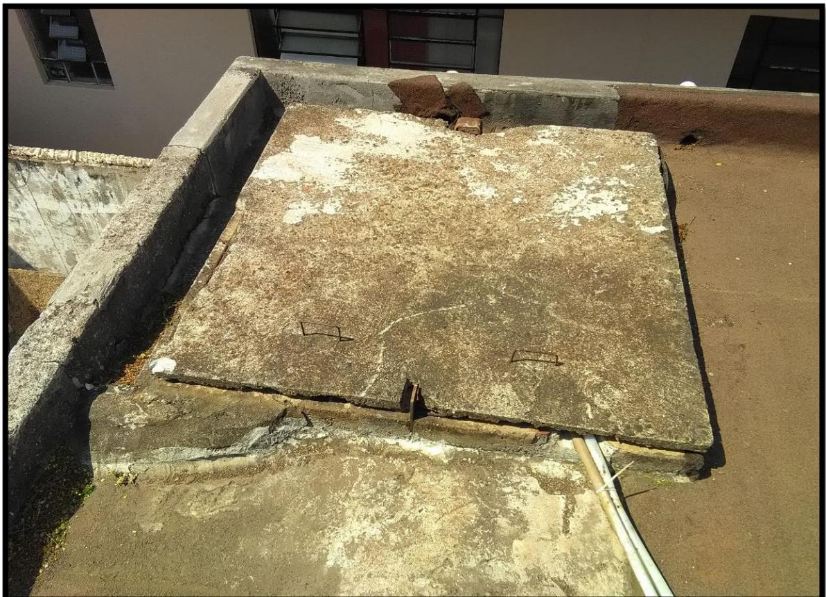
Imagem 8: Abertura de inspeção do reservatório apoiado
