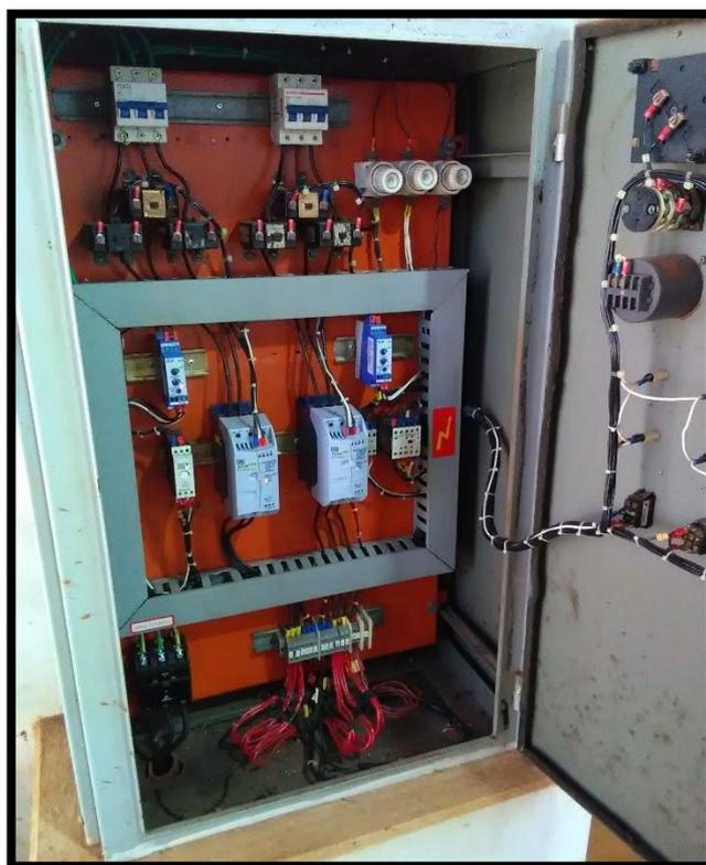
Imagem 15: quadro de comando da Estação elevatória de água tratada
