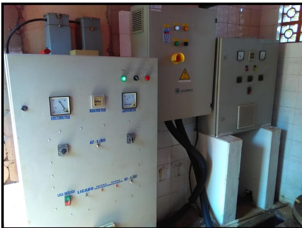
Imagem 13: quadro de comando da Estação elevatória de água bruta
