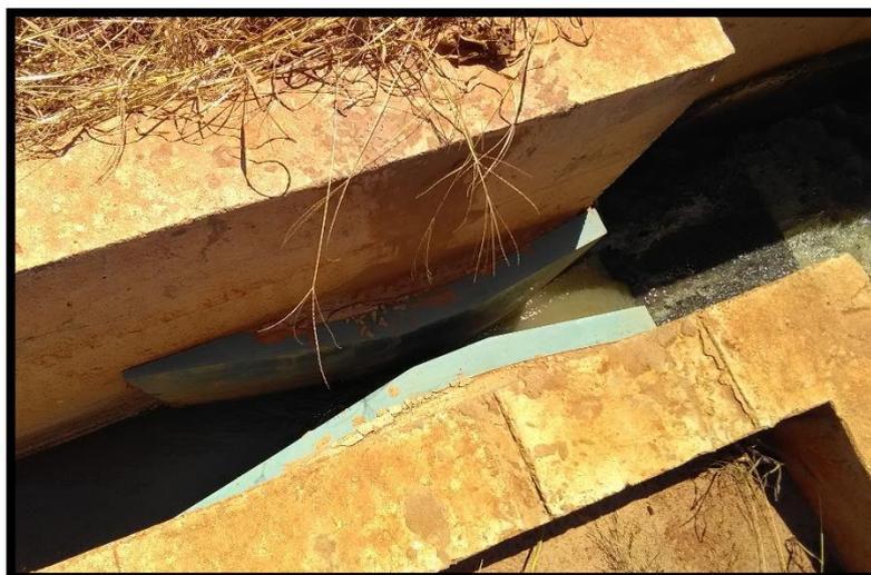
Imagem 27: Medidor de Vazão
