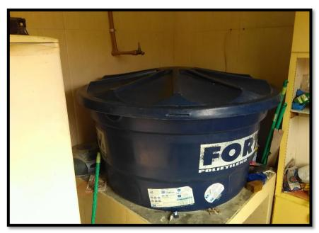
Imagem 10: reservatório de diluição de cloro da Unidade de tratamento
