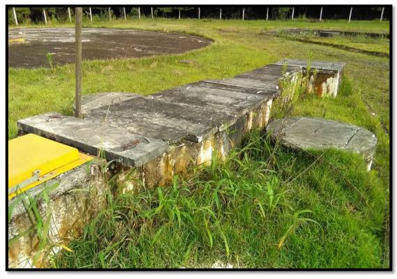
Imagem 20: Gradeamento, Caixa de areia e medidor de vazão
