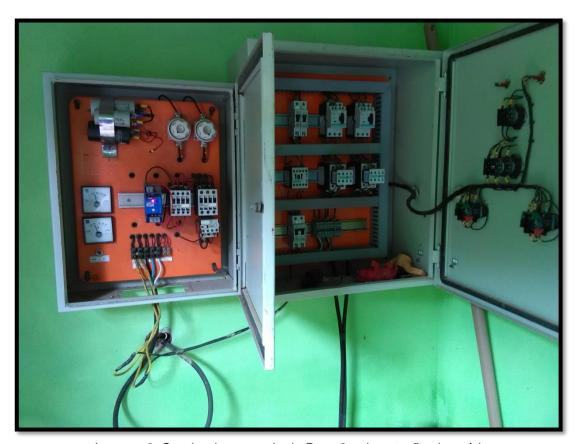
Imagem 9: Quadro de comando do Poço 2 e da estação elevatória
