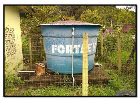
Imagem 14: Reservatório apoiado de fibra de 5m³
