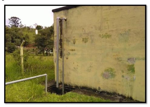
Imagem 12: Reservatório apoiado de concreto de 30m³
