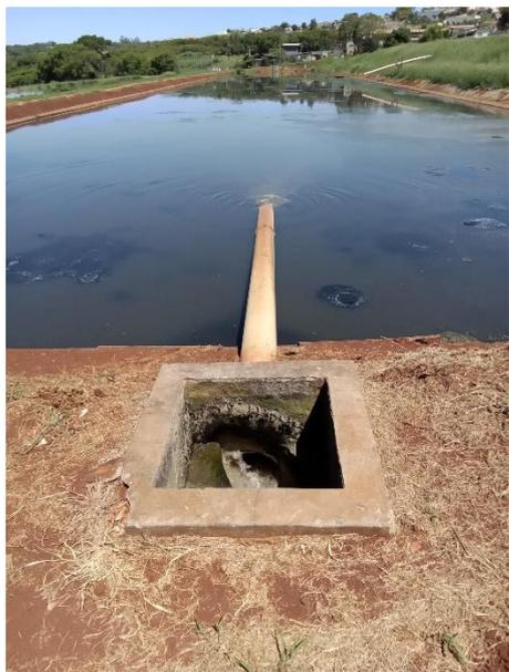
Foto 141 – Talude primeira lagoa anaeróbia danificado
