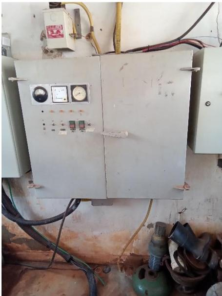
Foto 47 – Quadro de comando elevatória mina
