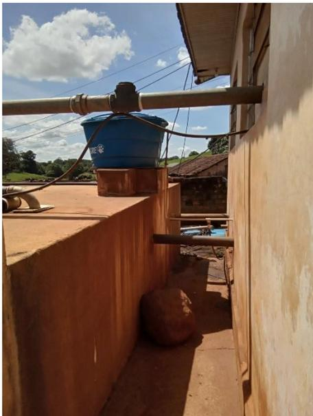
Foto 53 – Injeção de cloro UTA Canedo (mangueira azul) e depósito de insumos
